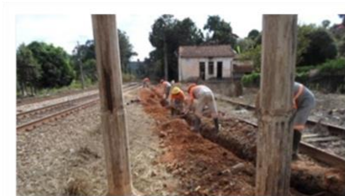
Figura 3. Equipe de manutenção trabalhando para encontrar falhas no cabo metálico multicondutor utilizado pelo sistema de controle de sinalização de vias ferroviárias.
